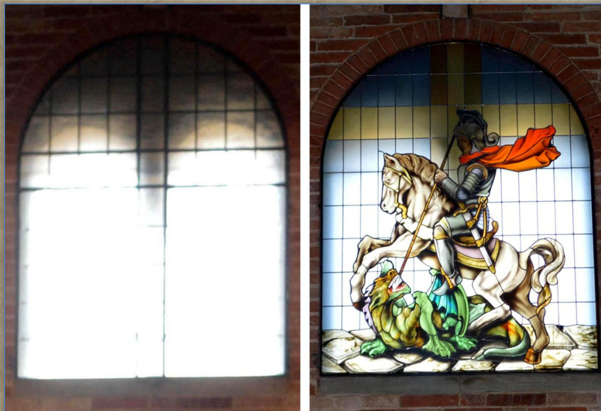
Interno del Tempio: la bifora come si presentava prima e come adesso, dopo la posa della vetrata
